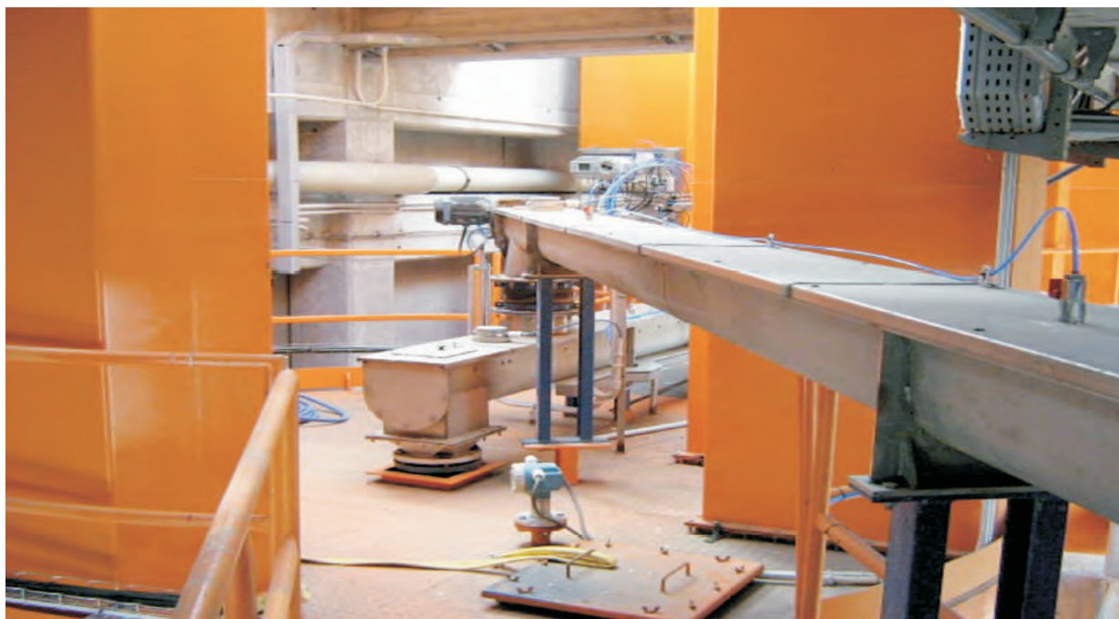
Figura 9. Zona de silos.
