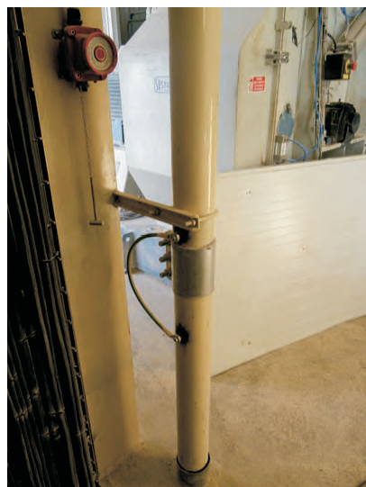
Figura 7. Puesta a tierra de conducción neumática.
